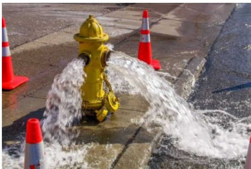
Płukanie sieci wodociągowej
