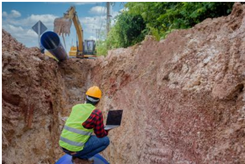
Budowa wodociągu i kanalizacji
